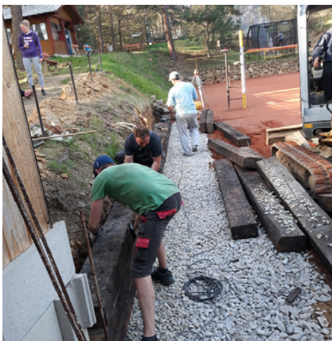
Zpevnění levého břehu u centrálního kurtu.
